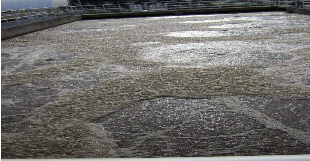
شكل رقم (5-6) وجود رغاوى سمراء بحوض التهوية
