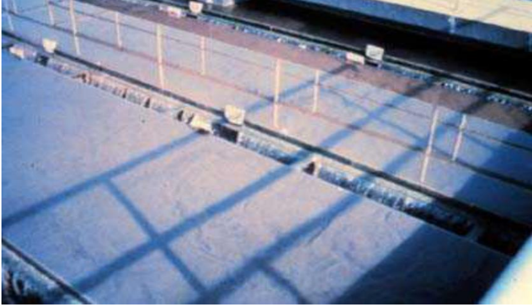
شكل رقم (5-9) أن سرعه ترسيب الحمأة بطيئة جدا
